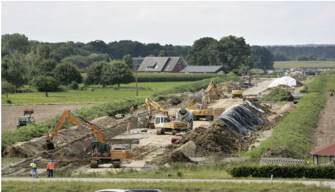
Abb. 5 Amprion-Baustelle einer 380-kVErdkabeltrasse bei Raesfeld (Quelle: Unterlage zur Antragskonferenz, S. 12)
