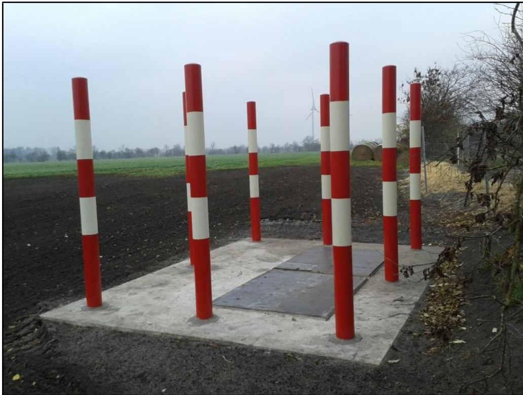
Abb. 22 Abdeckung eines Cross-Bonding-Schachtes mit Anfahrtsschutz (Quelle: TenneT)
