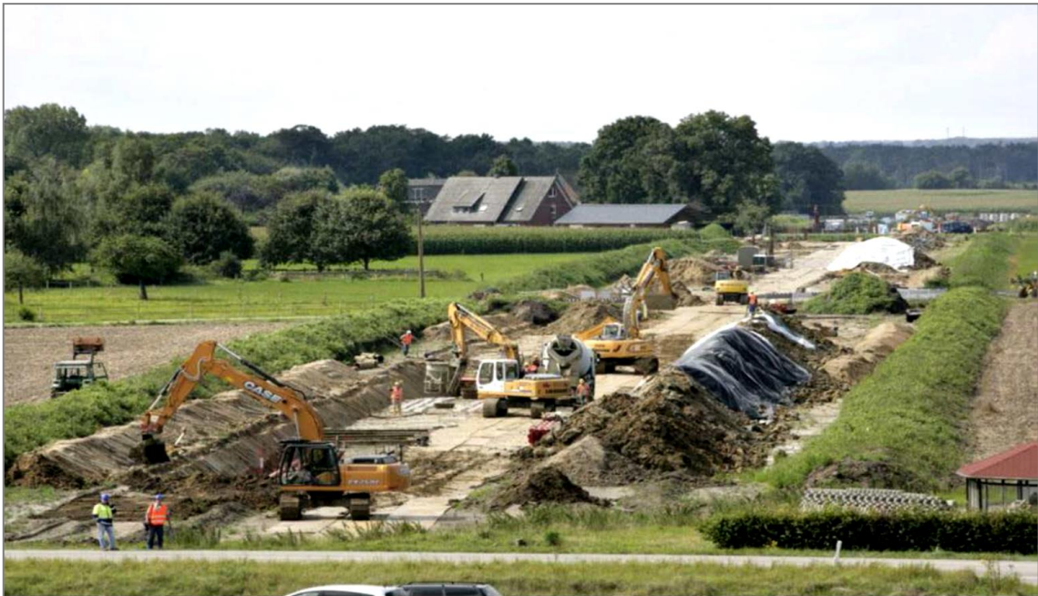
Abb. 6 Amprion-Baustelle einer 380-kV-Erdkabeltrasse bei Raesfeld (Quelle: Unterlage zur Antragskonferenz, S. 12)
