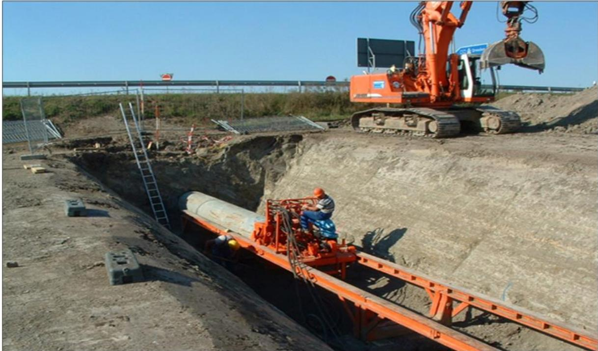
Abb. 3-7: Beispiel Unterpressung einer Straße (Pipelinebau) (eigene Aufnahme)
