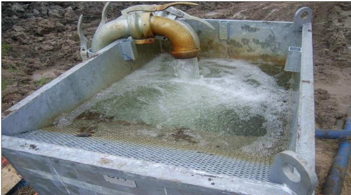
Abb. 3-5: Beispiel eines Klär- und Absetzbeckens (eigene Aufnahme)
