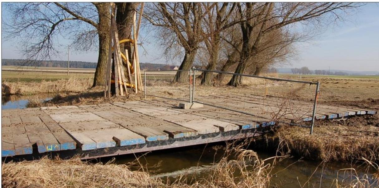
Abb. 3-3: Beispiel einer Gewässerüberfahrt mittels Pionierbrücke (eigene Aufnahme)
