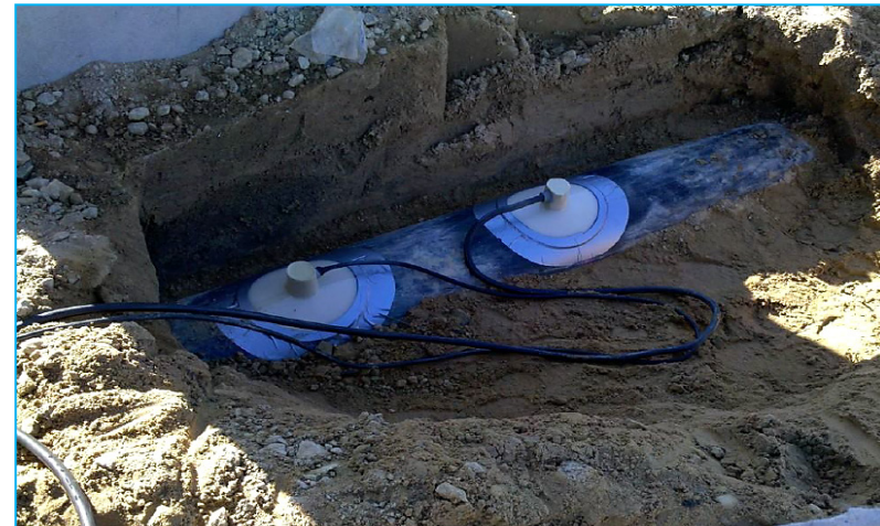
Messsensoren zur Leckageüberwachung
