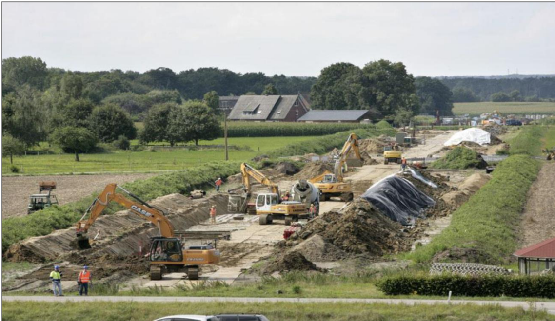
Abb. 5 Amprion-Baustelle einer 380-kV-Erdkabeltrasse bei Raesfeld
