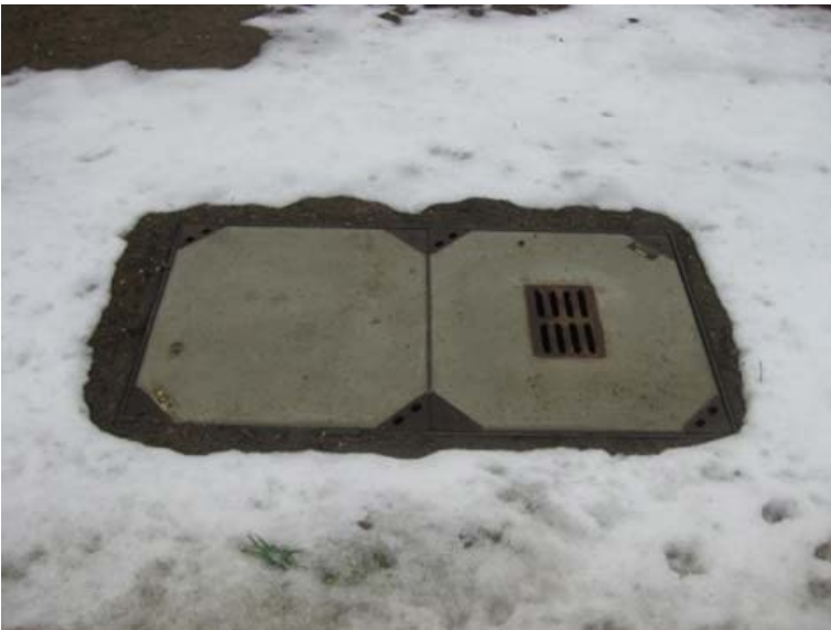
Abbildung 5: Crossbondingschacht, Beispiel (Quelle: Amprion)
