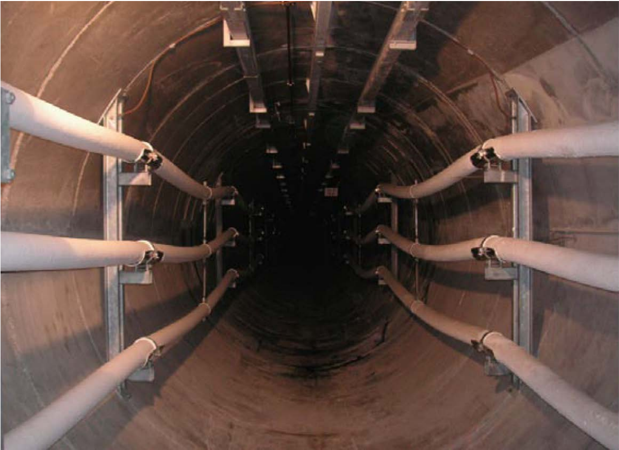
Abbildung 11: 380-kV-Kabel Berlin-Friedrichshain/Marzahn, Tunnelvariante (Quelle: DUH 2012)
