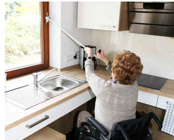
Die barrierefreie rollstuhlgerechte Küche im Erdgeschoss des Hauses erlaubt es den Bewohnerinnen und Bewohnern mit Hilfe von technischen Einrichtungen wie dem absenkbaren Hängeschrank oder von Hilfsmitteln wie dem Fensteröffner eigenständig zu leben
