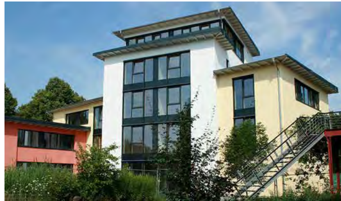
Kompetenzzentrum für Nachhaltiges Bauen in Verden, als direktverputzter strohballengedämmter Holzbau mit 5 Etagen in seiner Art der höchste in Europa
