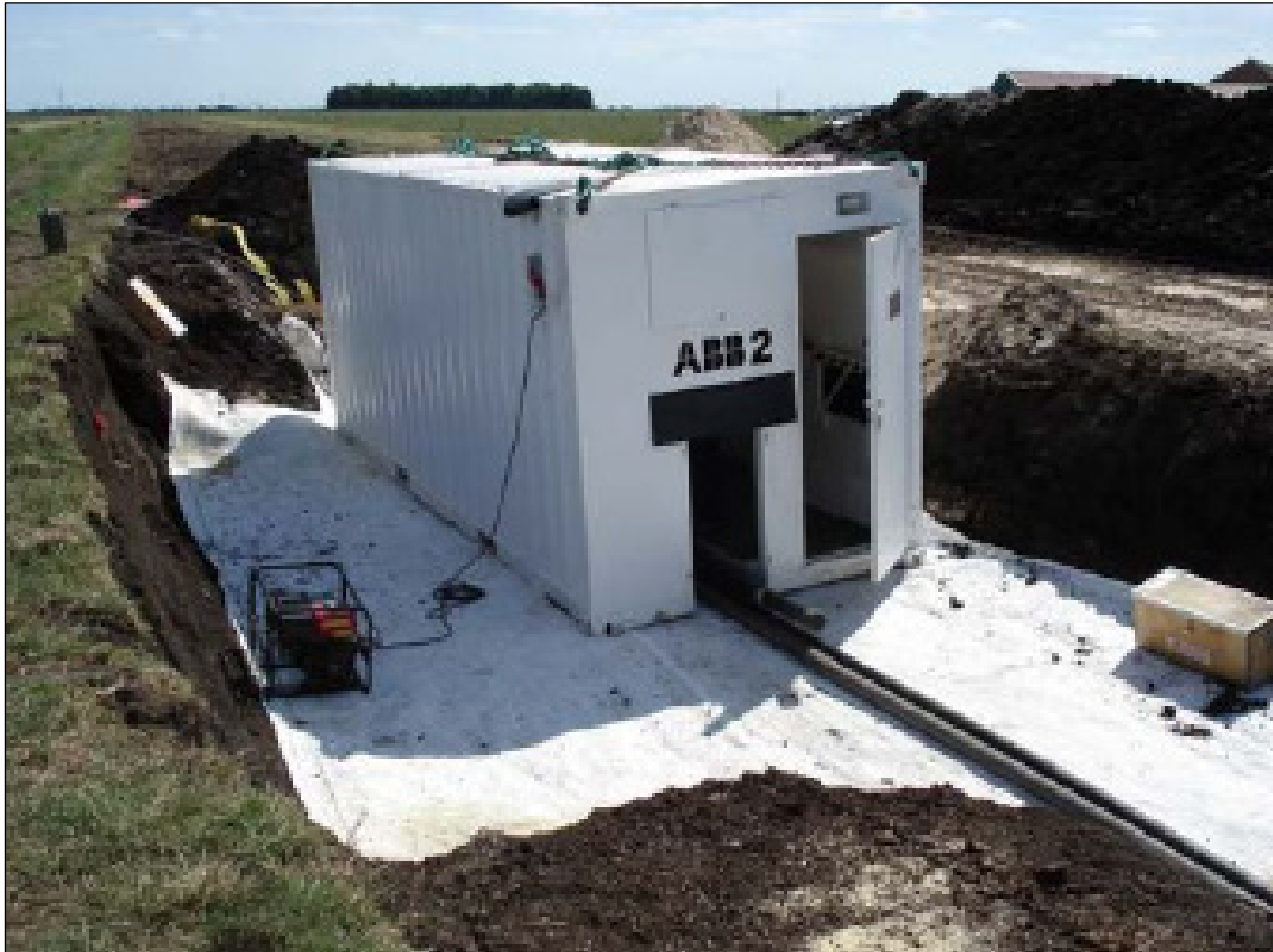
Foto 3.5-2: Muffengrube mit Arbeitscontainer
