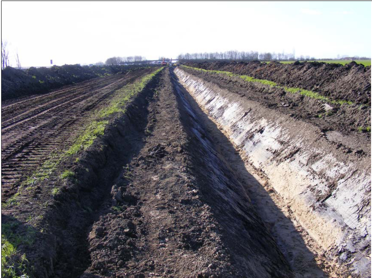
Foto 3.5-1: Graben bei offener Bauweise
