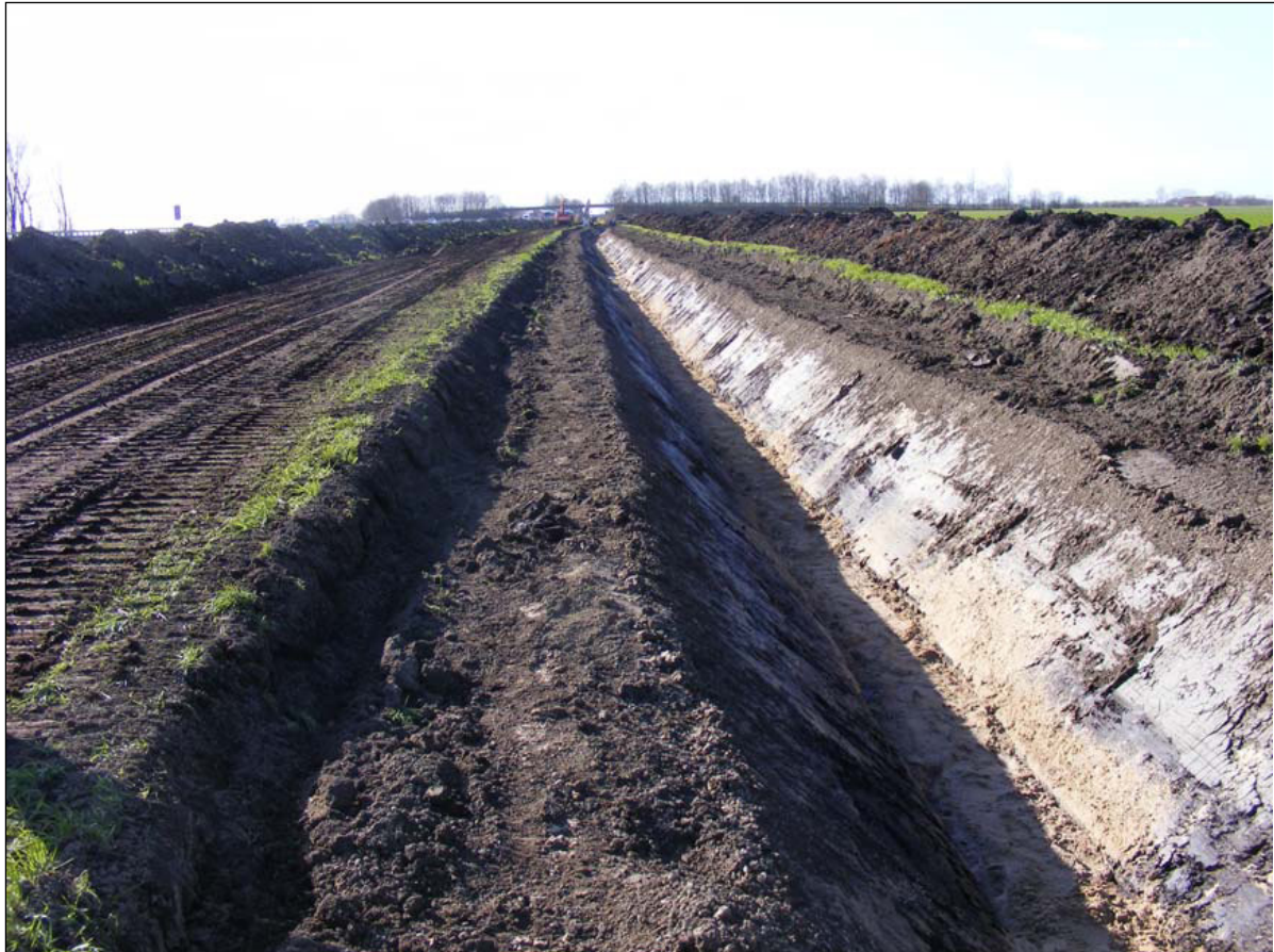
Foto 4.5-1: Graben bei offener Bauweise
