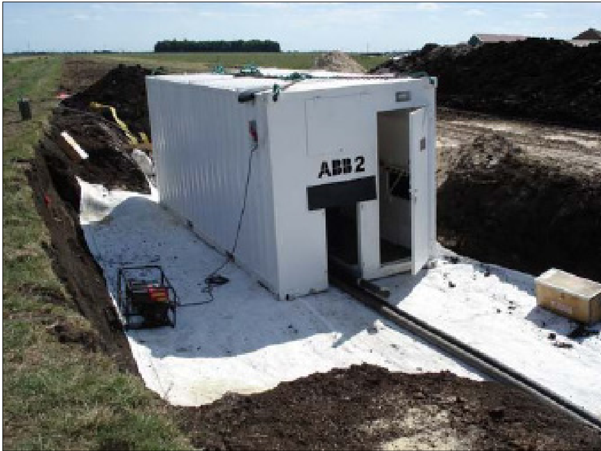
Foto 4.5-2: Muffengrube mit Arbeitscontainer
