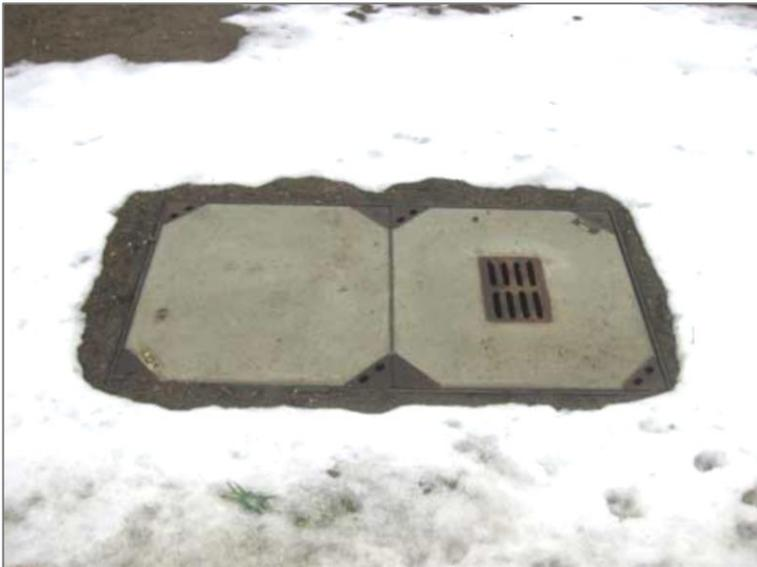
**Abb. 11** Crossbondingschacht, Beispiel (Quelle: Amprion)
