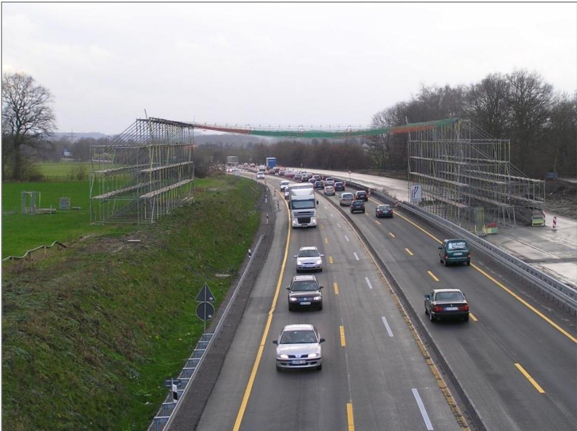
Abb. 2 Stahlrohrschutzkonstruktion mit Netz über einer Autobahn
