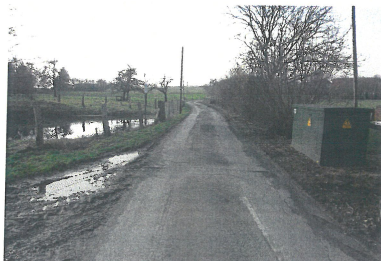
E. Nr. 121, Blick in westliche Richtung, Der mangelnde Unterbau hält den Gewichtsbelastungen nicht mehr stand.
