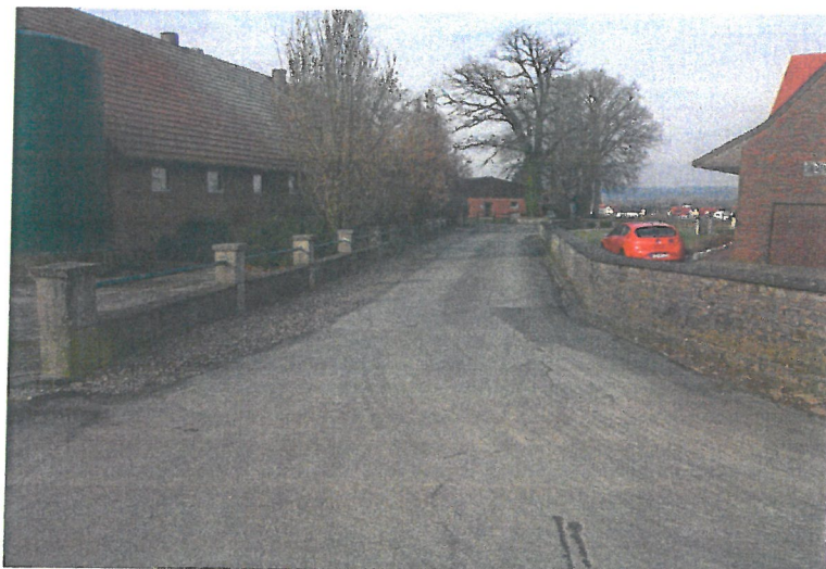
Blick von der Aufmündung auf die E. Nr. 122 in nördliche Richtung, Am rechten Fahrbahnrand ist eine Abflussmulde anzulegen.
