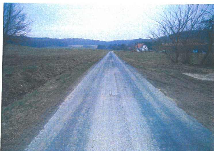
Wegeabschnitt E. Nr. 107.20, Blick in westliche Richtung
