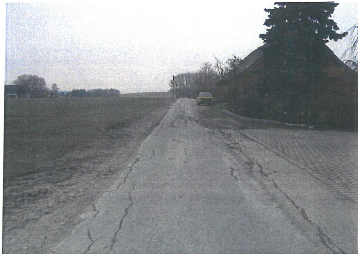
Die Absackungen, hervorgerufen durch die extremen Gewichtslastungen auf dem für diese Tonnagen nicht ausgelegtem Unterbau sind deutlich zu erkennen.
