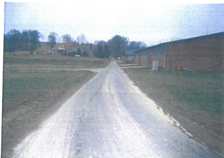
Aufnahme des in Nord- Südrichtung verlaufenden Abschnitts, Blick vom Kurvenbereich in nördliche Richtung
