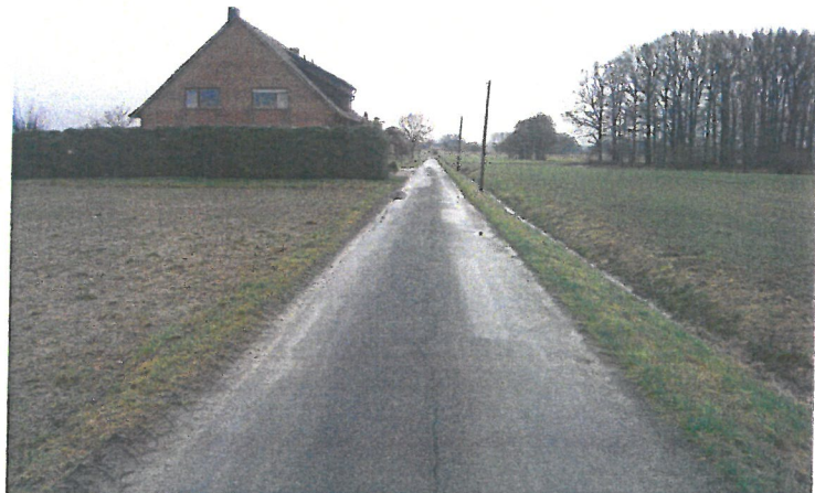
Gut zu sehen ist die extreme Wannenbildung, die ein Befahren mit normalem Personenkraftwagen kaum mehr erlaubt.
