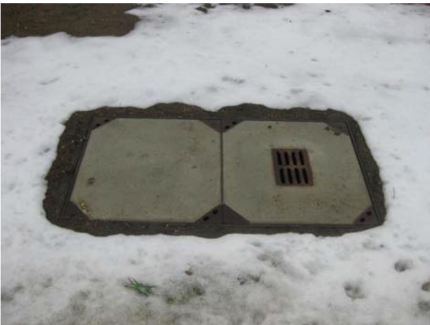
Abbildung 16: Crossbondingschacht, Beispiel (Quelle: Amprion)
