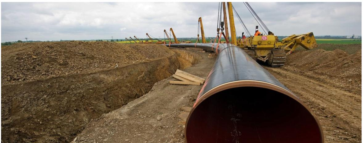
Abbildung 5: Absenken des Rohrstranges
