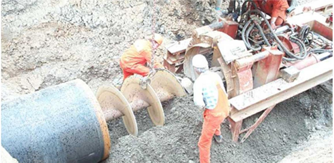
Abbildung 6: Beispiel Pressbohrverfahren
