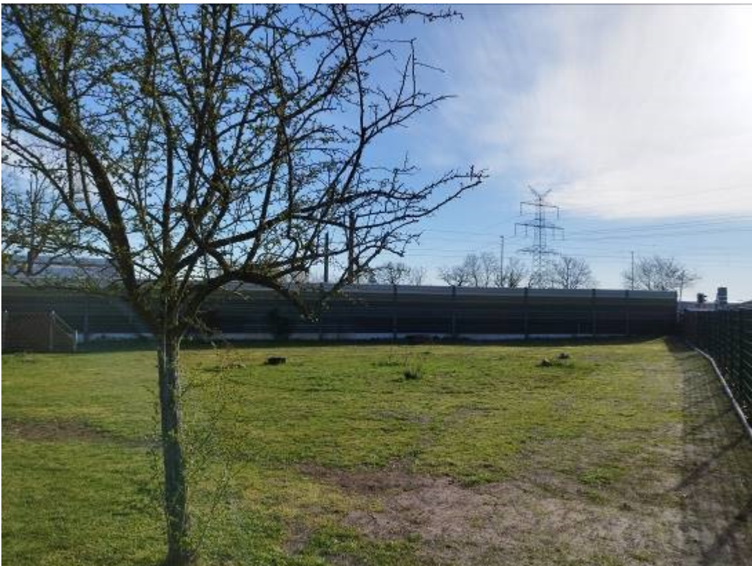
Abbildung 16: Sicht auf Bestandsleitung, Bahnstrecke und Baustoffhändler Garms von betroffenem Grundstück; Sahrener Weg.
