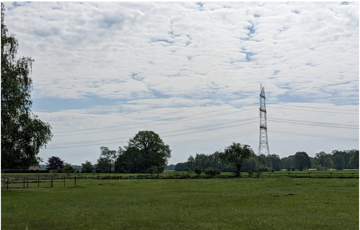
Abbildung 10: Sicht auf die Bestandsleitung von betroffenem Grundstück (Foto 3); „Zur Ollen“.
