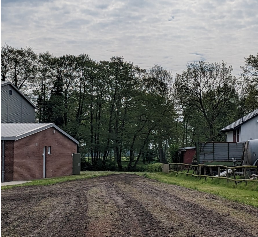
Abbildung 9: Sicht auf die Bestandsleitung von betroffenem Grundstück (Foto 2); „Zur Ollen“.
