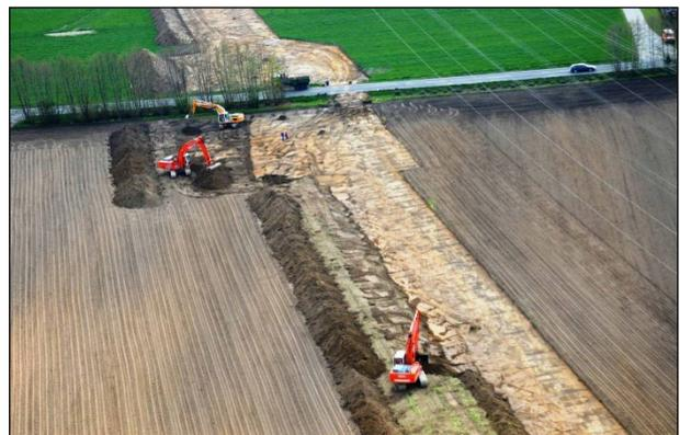
**Abbildung 10: Abheben und lagern des Mutterbodens**
