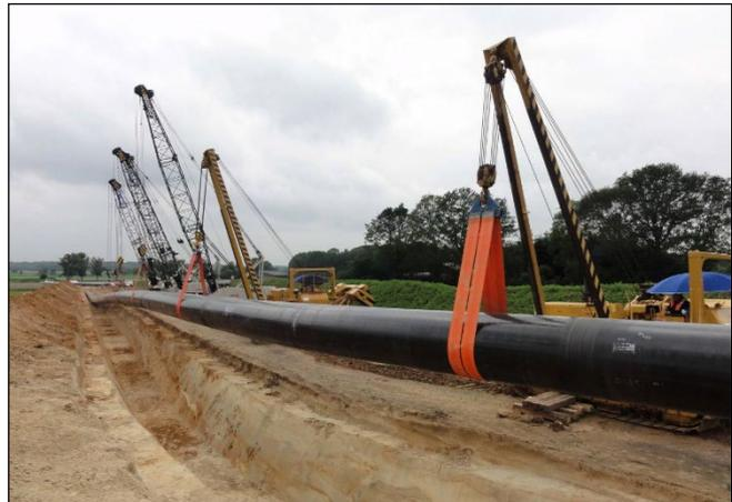
**Abbildung 14: Absenken des Rohrstranges mit Seitenbäumen / Rohrlegern und Seilbaggern**
