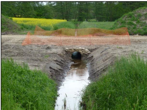
**Abbildung 9: Überfahrt über einen wasserführenden Graben**
