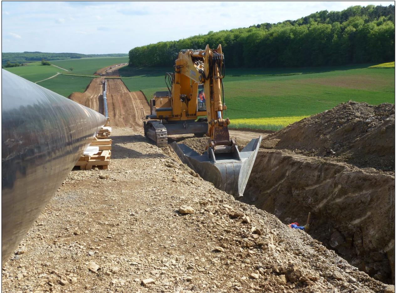
**Abbildung 13: Rohrgrabenaushub**
