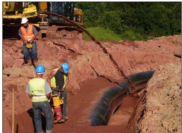
**Abbildung 15: Verfüllen des Rohrgrabens**
