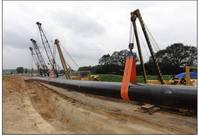
Abbildung 23: Absenken des Rohrstranges mit Seitenbäumen / Rohrlegern und Seilbaggern
