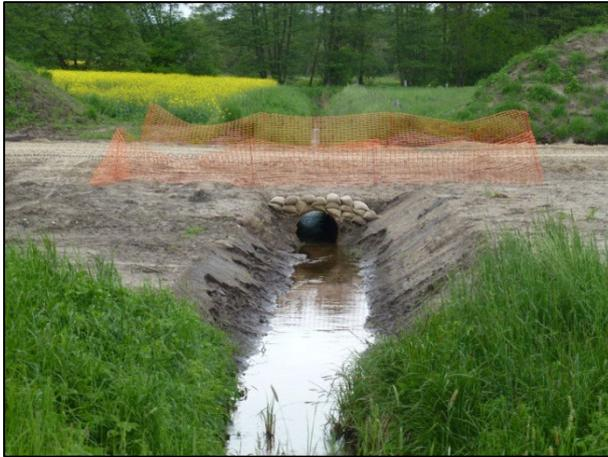
**Abbildung 18: Überfahrt über einen wasserführenden Graben**
