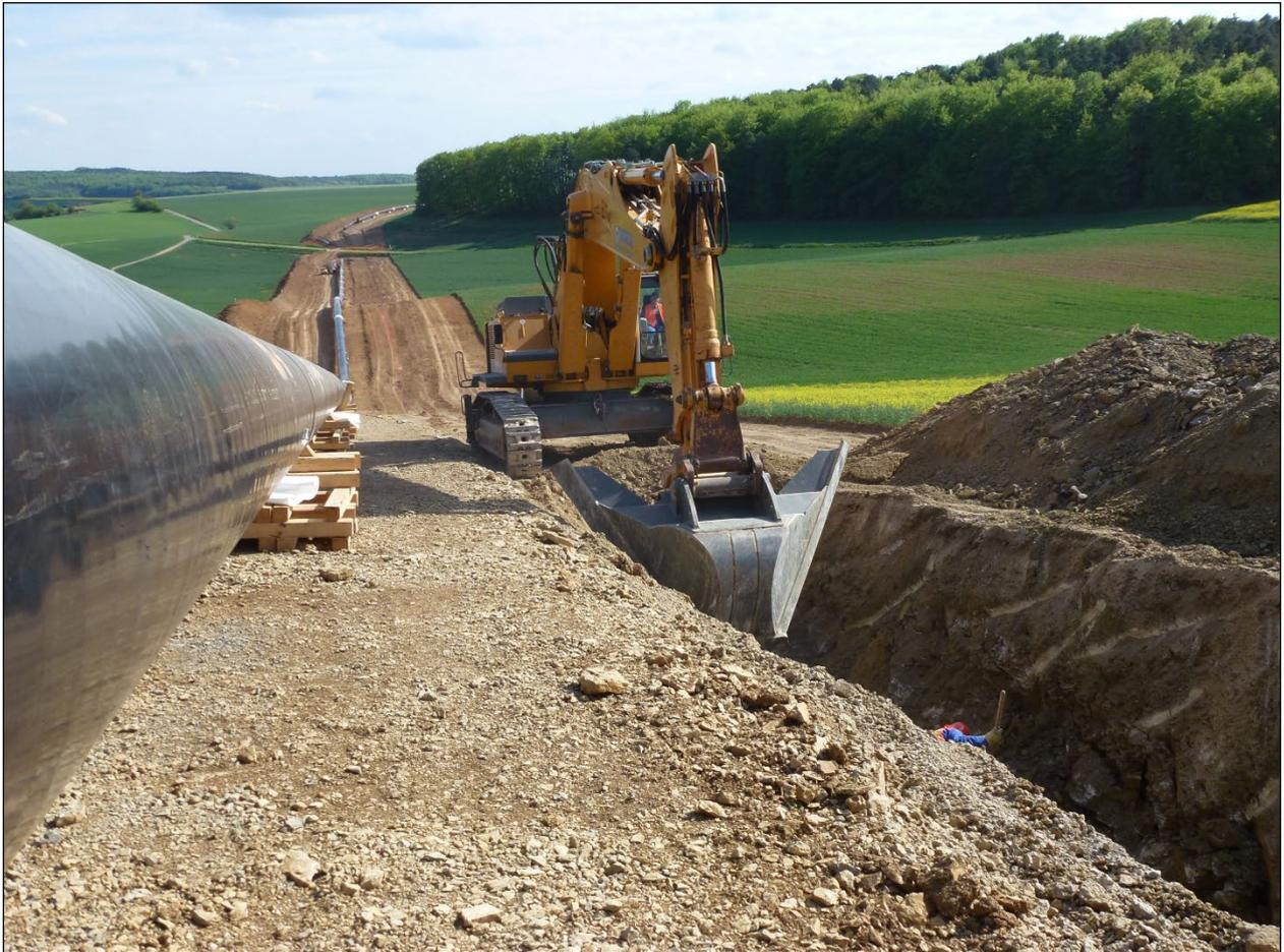
**Abbildung 22: Rohrgrabenaushub**
