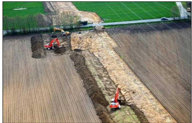
**Abbildung 19: Abheben und lagern des Mutterbodens**
