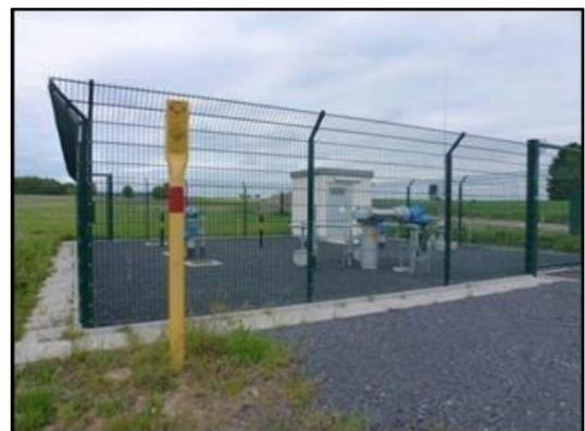
**Abbildung 16: Beispielbild einer Armaturenstation mit Übersteigenschutz und Technikcontainer**
