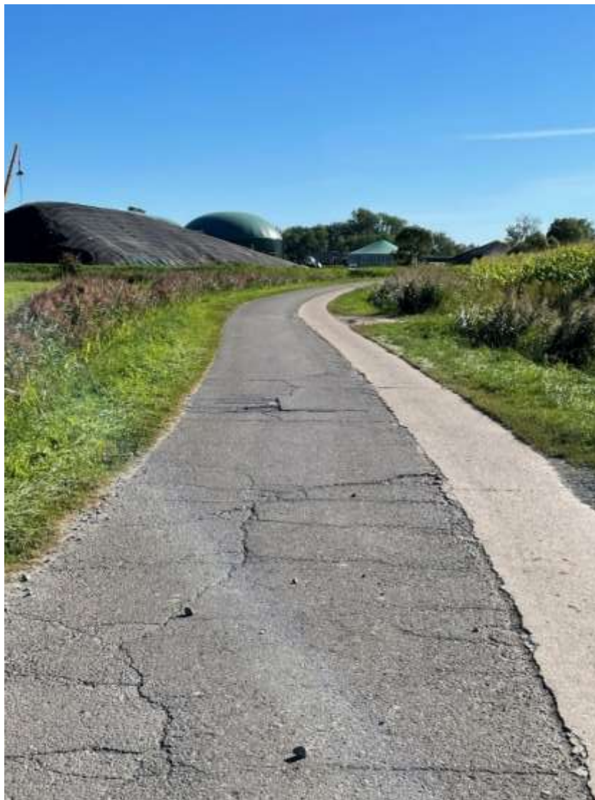
Abbildung 10: Isenser Burweg nördlich der Biogasanlage, Bauabschnitt 101.10
