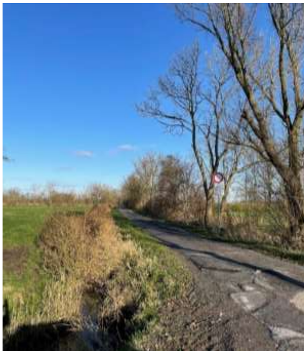
Abbildung 26: Knappenburger Weg südlicher Bauabschnitt, Blick nach Norden
