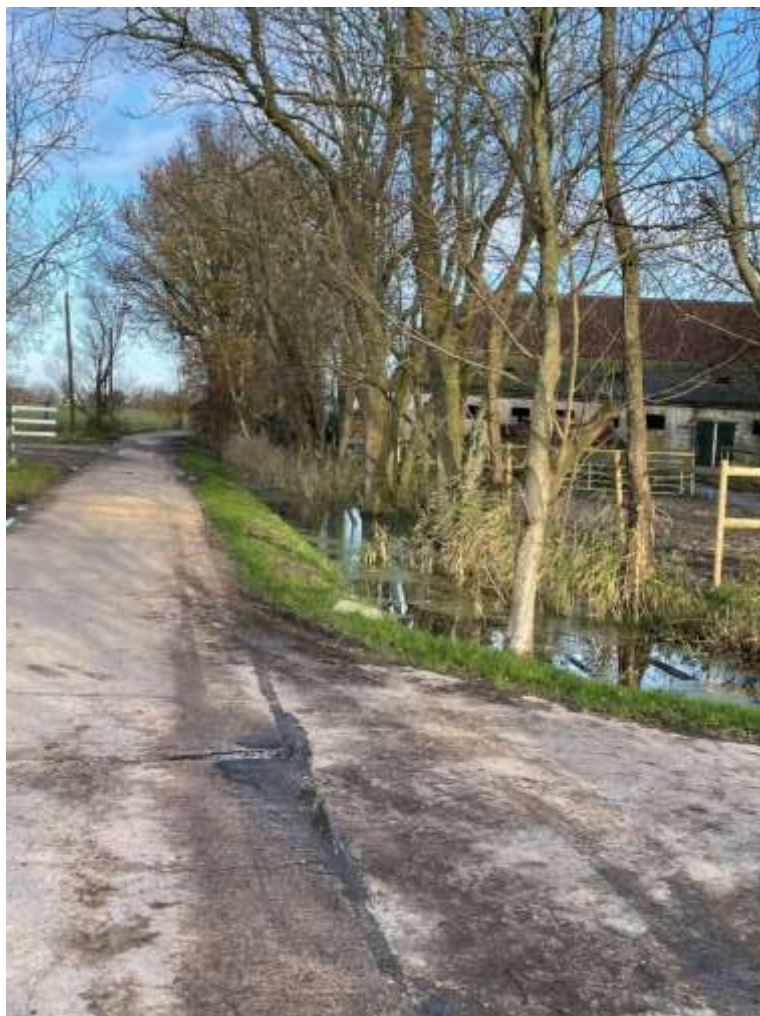
Abbildung 8: Teilverfüllung des Grabens am Knappenburger Weg, Schaffung einer Mulde E.-Nr. 103.30
