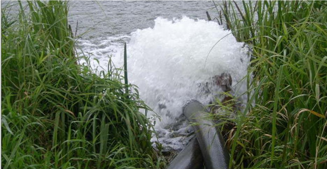
Abb. 4-2: Teilschutzgut Oberflächengewässer - Beispiel einer Einleitung von Bauwasser (Quelle: eigene Darstellung)
