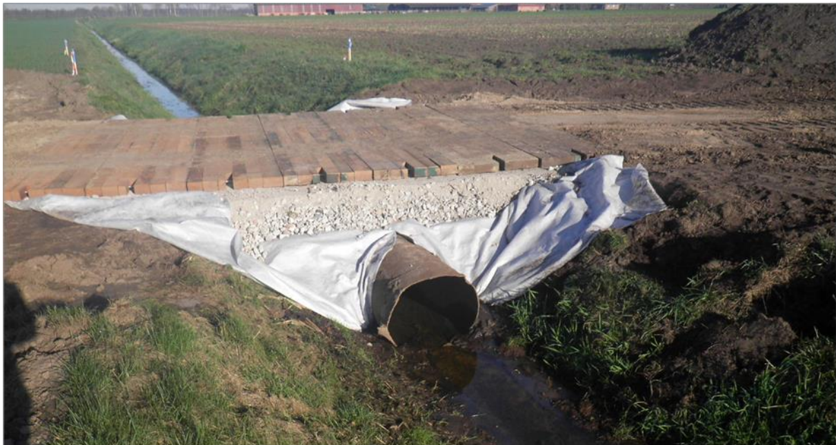
Abb. 4-1: Teilschutzgut Oberflächengewässer - Beispiel einer Gewässerüberfahrt mittels temporärem Rohrdurchlass (Quelle: eigene Darstellung)
