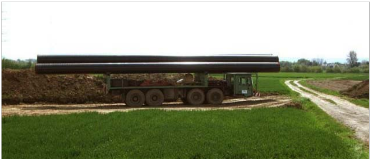
Abb. 3 Ausfahren der Rohre
