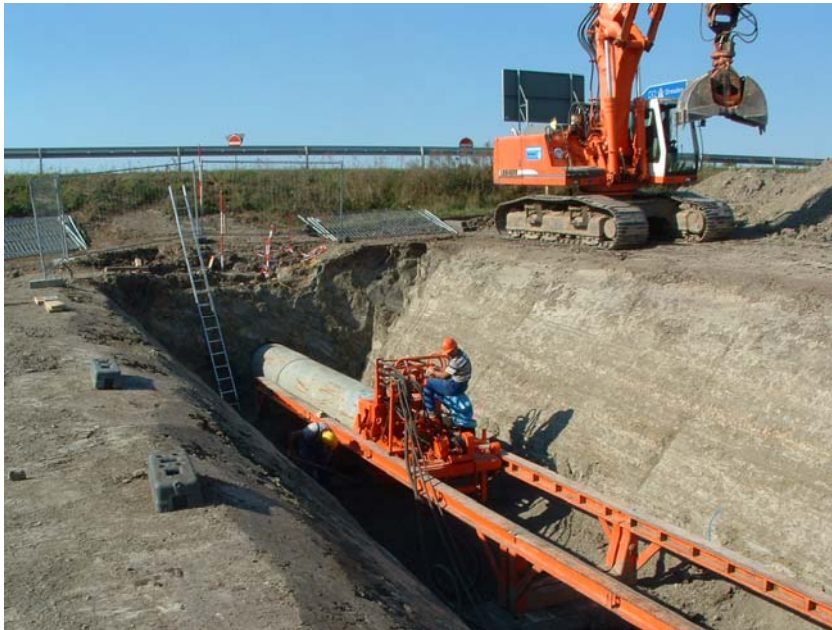
Abb. 11 Beispiel für das Horizontal-Bohrpressverfahren
