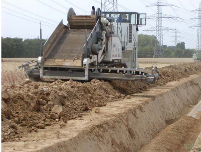
Abb. 10 Einsandung durch Paddereinsatz
