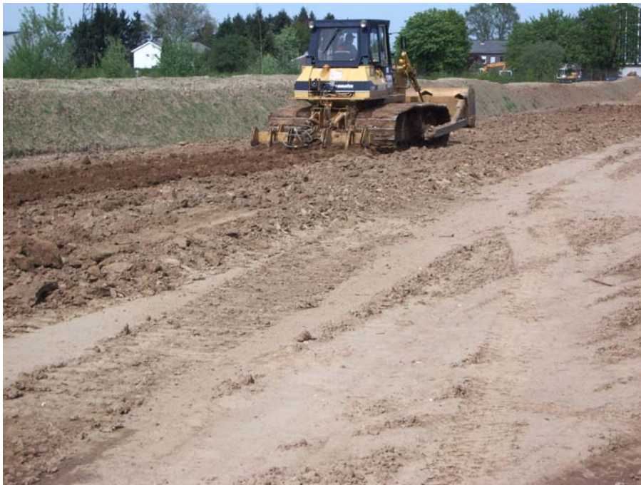
Abb. 12 Bodenauflockerung vor dem Auftrag des Oberbodens (Standardverfahren mit Aufreißhaken)
