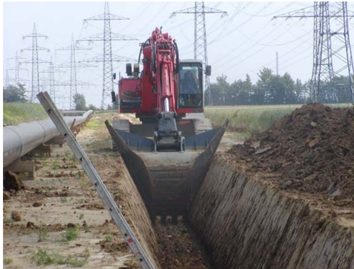
Abb. 7 Aushub des Rohrgrabens
