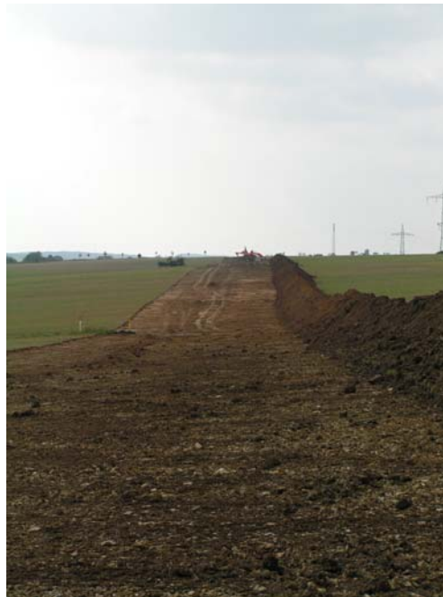
Abb. 2 Seitliches Lagern des abgeschobenen Oberbodens im Arbeitsstreifen
