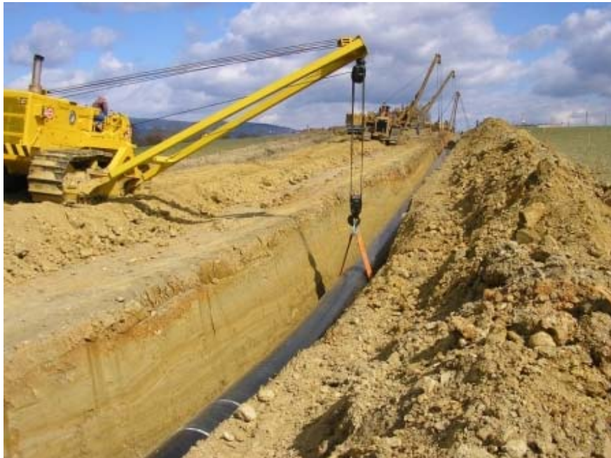
Abb. 8 Absenken eines fertig geschweißten und geprüften Rohrstranges
