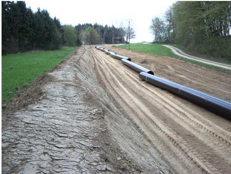
Abb. 4 Linierte Rohre im Arbeitsstreifen
