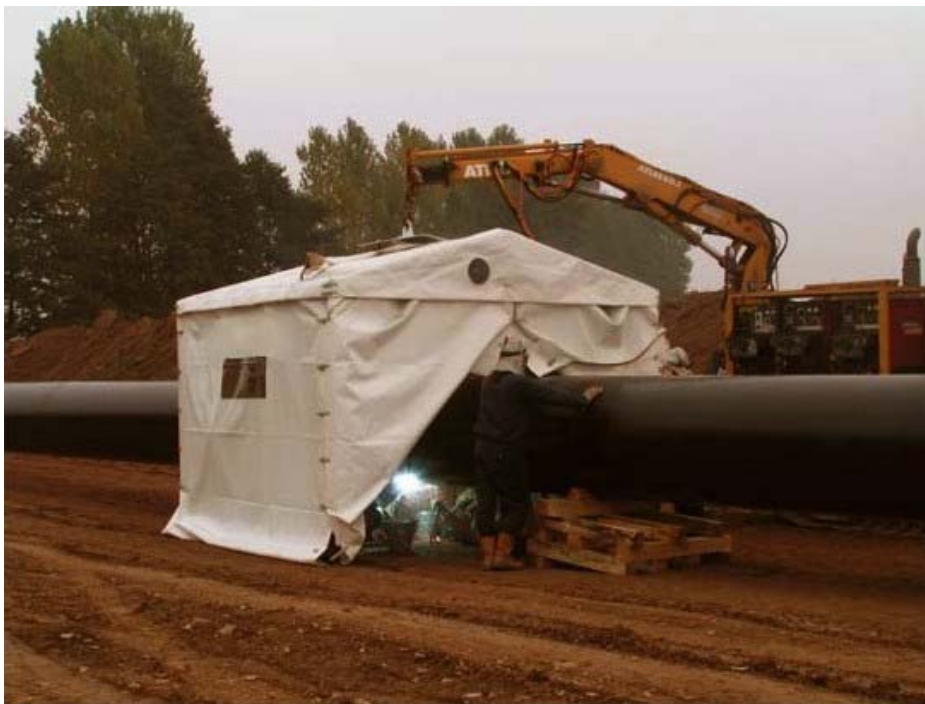
Abb. 5 Verschweißen der Einzelrohre zu einem Rohrstrang
