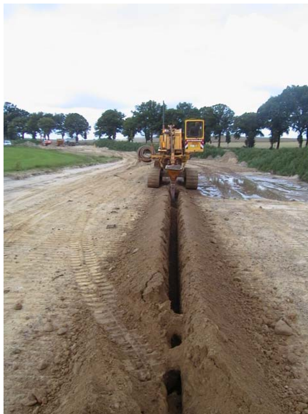
Abb. 6 Einfräsen des Horizontaldräns
