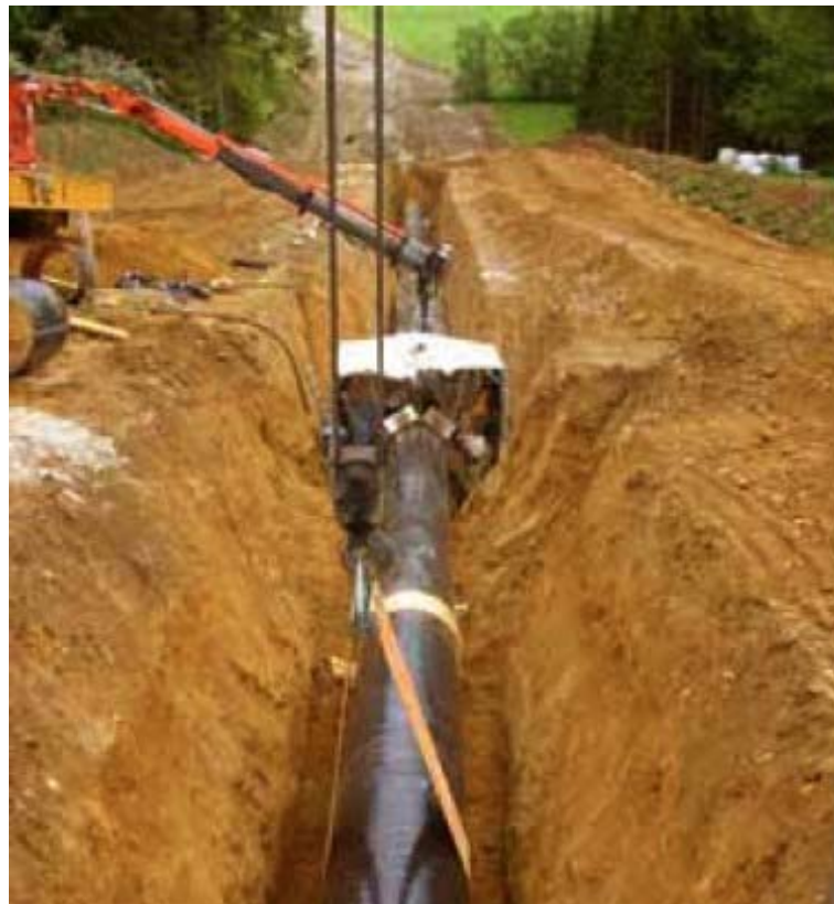
Abb. 9 Verschweißen zweier Rohrstränge im Rohrgraben
